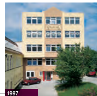
1997 Erweiterung Bürogebäude, Studios und Museum Enlargement of the office building, studios and museum
